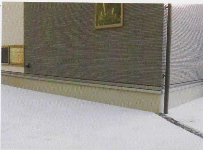
基礎パッキング住宅に取り付け
