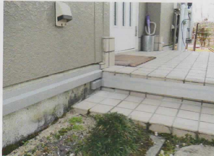
軽量鉄骨住宅 基礎と玄関ポーチに取り付け
