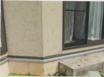
洋風住宅 基礎に取り付け
